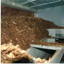
La chaufferie bois du centre technique municipal de la Ville de Chambéry, d'une puissance de 700 kW, permet de couvrir une grande partie des besoins en chauffage des locaux et des serres
