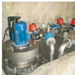
Picocentrale de 5,5 kW sur le réseau d'eau potable de Montvalezan, au niveau du réservoir du Lièvre Blanc, à la station de la Rosière.
